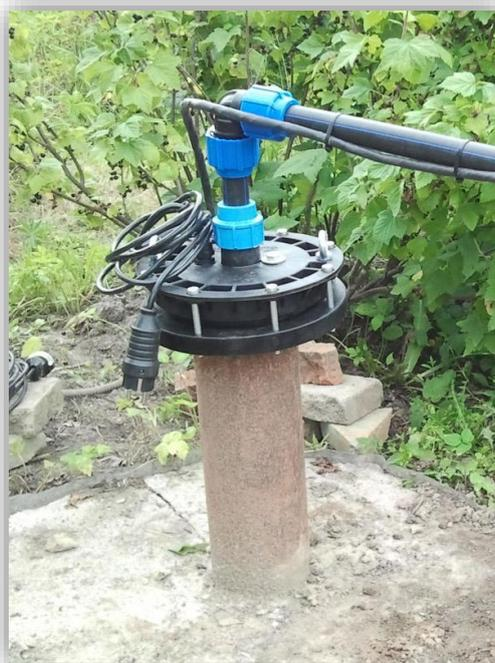
Рисунок 4.9. Водозаборная скважина с герметичным оголовком
