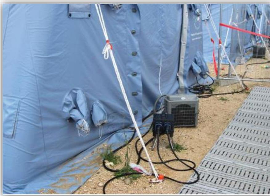
Рисунок 6.3. Индивидуальная выносная инверторная система многоместной палатки
